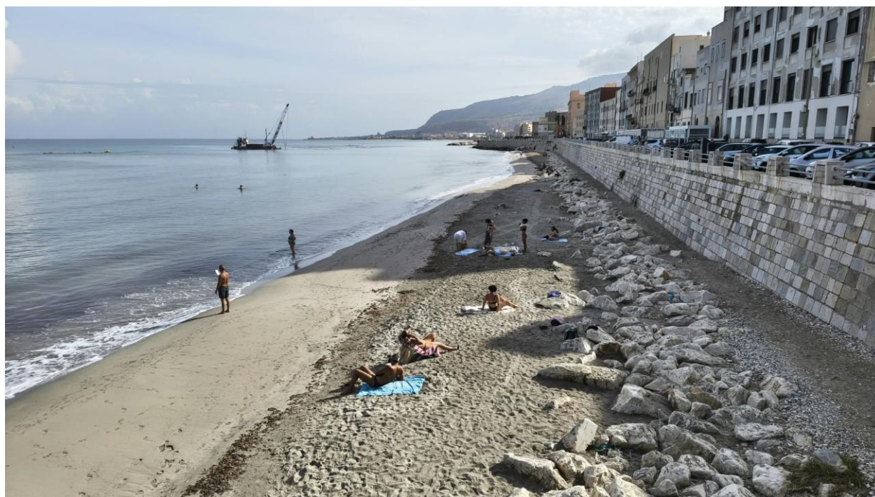
Fig. 14bis.3 – Prospettiva dal basso del litorale sabbioso urbano lungo il Lungomare Dante Alighieri, nel tratto che collega la Spiaggia della Pescheria alla Spiaggia di San Giuliano. Lo scatto mette in evidenza la scogliera frangiflutti artificiale a protezione del muraglione cittadino, l'arenile frequentato dai bagnanti e il profilo della costa ericina sullo sfondo. Foto dall'Archivio Fotografico Ufficiale del Trapani Camper Club utilizzata per motivi divulgativi e associativi senza scopo di lucro.
