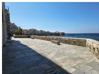
Via Mura di Tramontana Ovest Trapani
