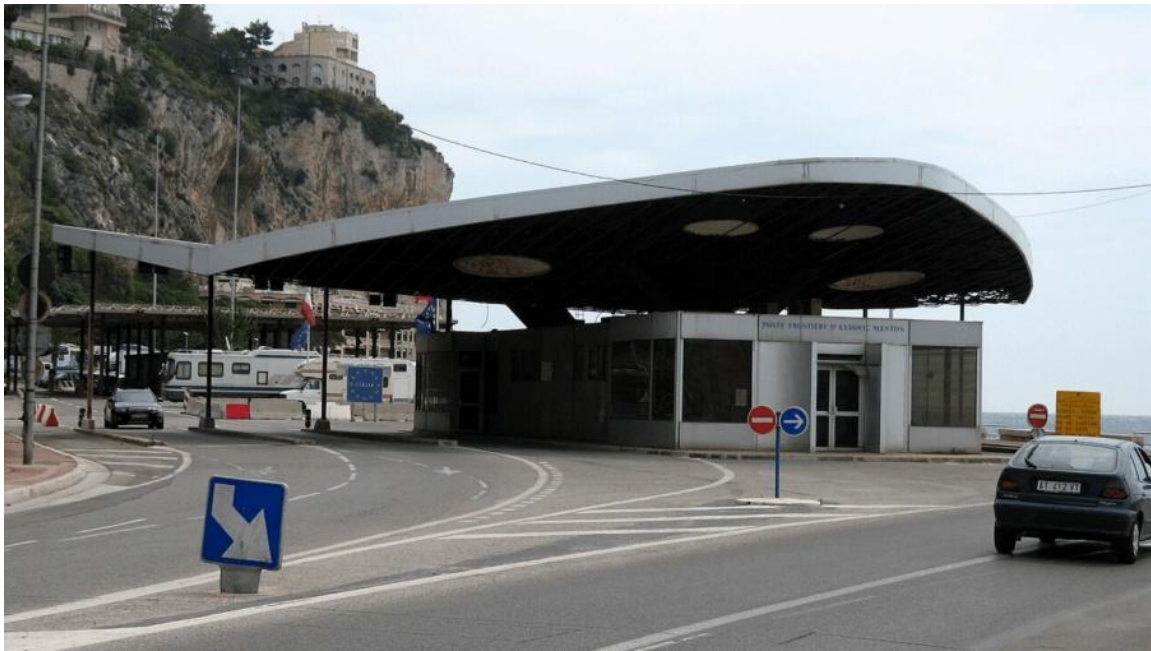
Il Valico di Frontiera stradale di Ponte San Ludovico (Poste Frontière St Ludovic) tra Ventimiglia e Mentone.
