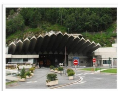
L'ingresso monumentale del Traforo del Monte Bianco sul versante francese nei pressi di Chamonix. (Foto: Archivio Libero Wikimedia Commons, utilizzata sotto licenza Creative Commons per uso editoriale e informativo senza scopo di lucro).
