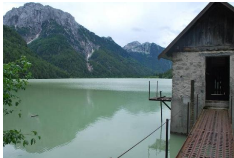
Dettaglio della passerella d'accesso e della storica stazione di pompaggio sul Lago del Predil. (Foto: Archivio privato Trapani Camper Club, riprodotta su autorizzazione degli autori).
