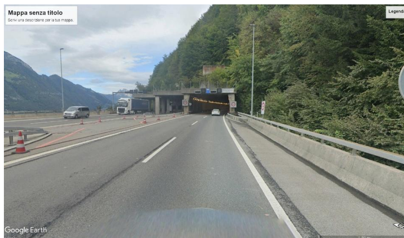
Il portale sud (ingresso di Airolo) del Traforo Stradale del San Gottardo lungo l'autostrada A2. Fonte: Google Earth / Street View (Utilizzata a scopo puramente informativo e senza fini di lucro).
