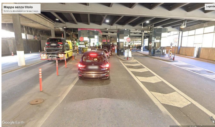
La barriera di esazione e le cabine di pagamento del pedaggio sul versante svizzero del Traforo del Gran San Bernardo. Fonte: Google Earth / Street View (Utilizzata a scopo puramente informativo e senza fini di lucro).
