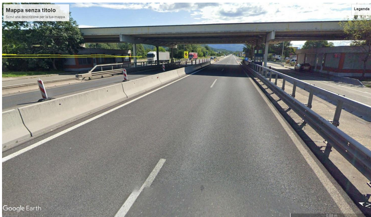
L'avvicinamento stradale alla pensilina dell'ex dogana e la linea di confine di Stato al Valico di Sant'Andrea in direzione della Slovenia. Fonte: Google Earth / Street View (Utilizzata in conformità alle Linee Guida di Google per uso editoriale, educativo e informativo non commerciale, senza fini di lucro).
