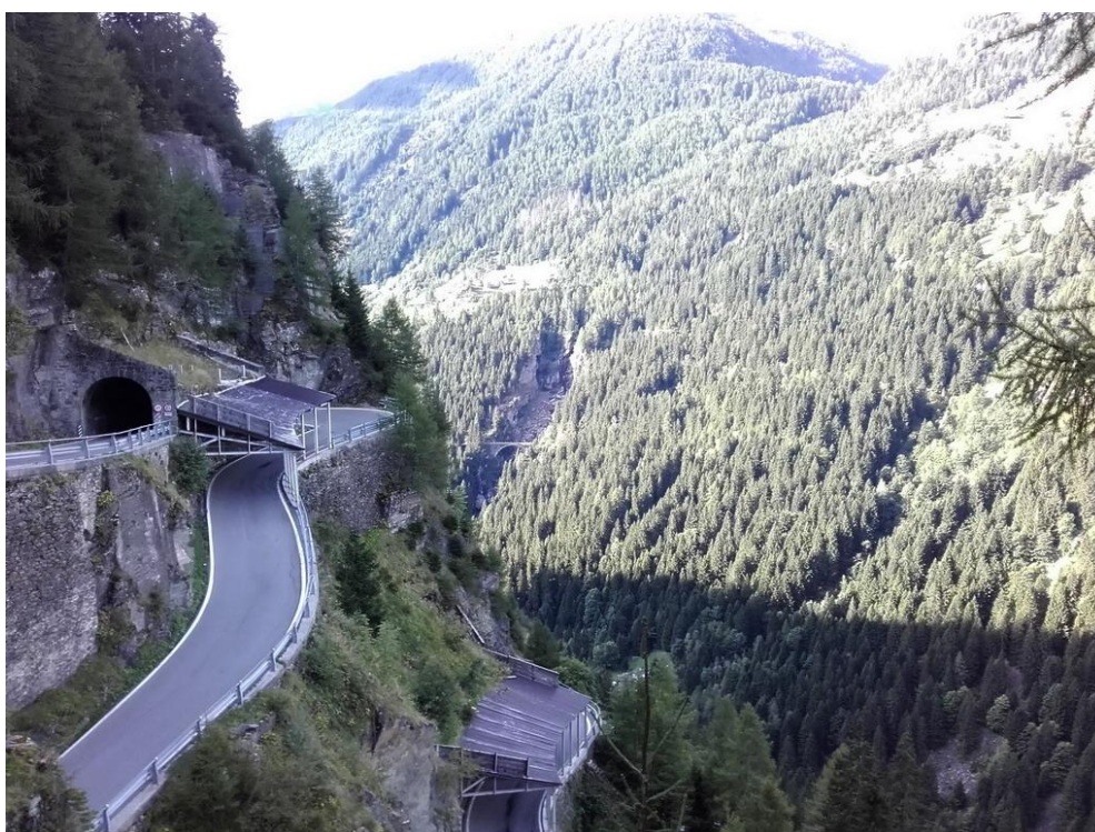
I ripidi tornanti paravalanghe della Strada Statale 36 sul versante italiano del Passo dello Spluga, caratterizzati da carreggiate strette e volte rocciose convesse. (Foto: Archivio Libero Wikimedia Commons, utilizzata sotto licenza Creative Commons CC-BY-SA per uso editoriale e informativo senza scopo di lucro).
